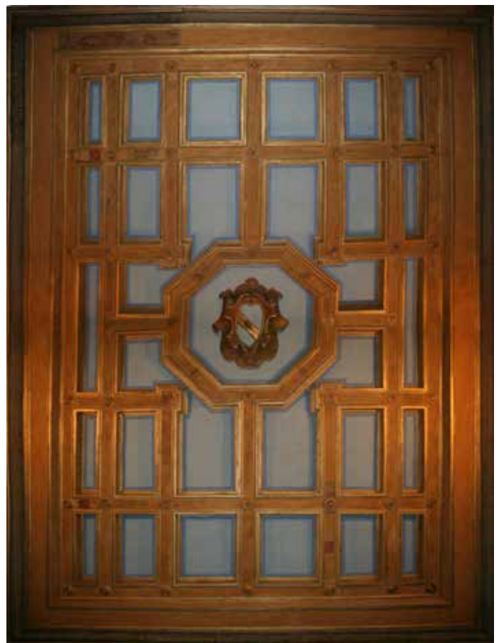
Restauro soffitto ligneo Sale delle Caccie Palazzo Orsini Barberini
