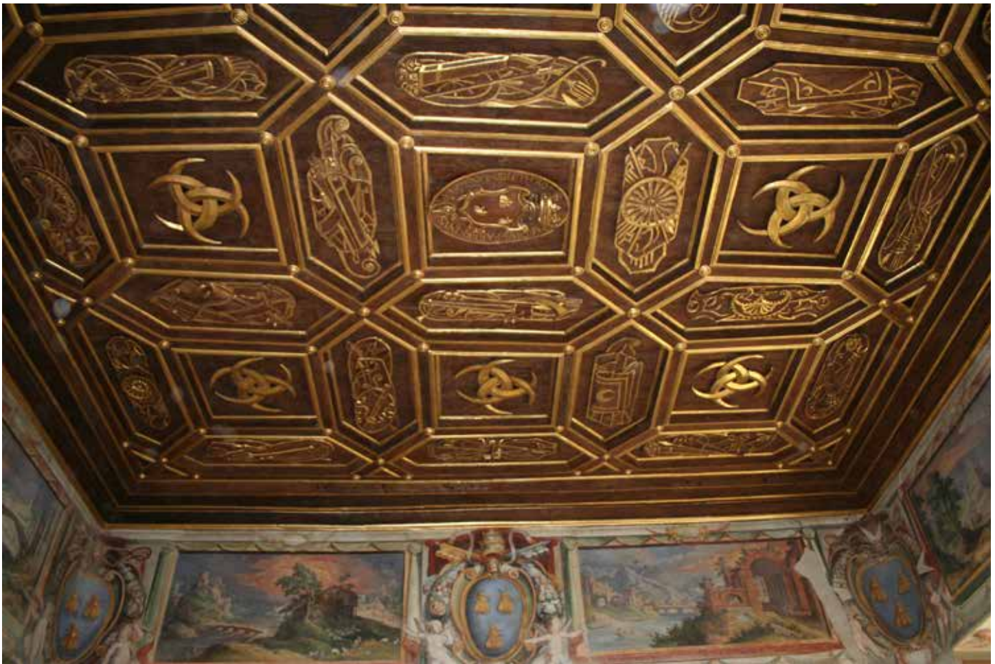
Restauro soffitto ligneo intagliato e dorato Palazzo Orsini Barberini
