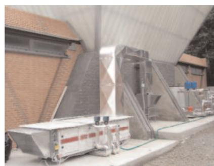
Fig. 14 - Fase di musealizzazione, impianto di trattamento dell'aria.
