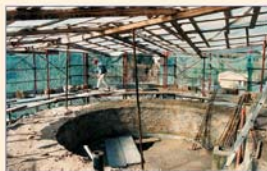
Particolare durante gli interventi di restauro
