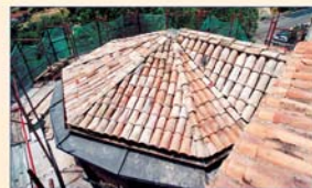
Copertura in coppi del Torrione
