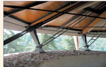
Particolare della struttura metallica portante della copertura
