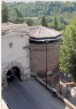
L'arco di entrata e il Torrione durante i lavori
