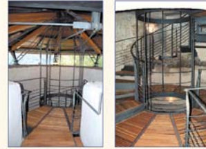
Particolari della scala in ferro e legno
