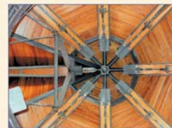
Particolare della struttura metallica portante della copertura
