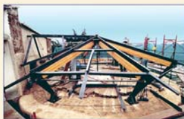
Copertura: particolare della carpenteria metallica
