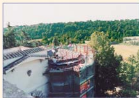
Particolare della copertura durante i lavori
