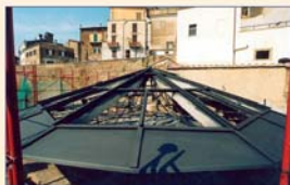
Copertura: particolare della carpenteria metallica
