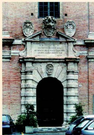
portale della Chiesa dopo il restauro
