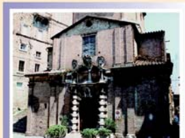
Particolare del portale prima del restauro
