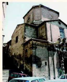
la Chiesa prima del restauro
