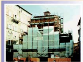
La Chiesa durante le fasi di restauro
