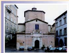
La Chiesa dopo gli interventi di restauro
