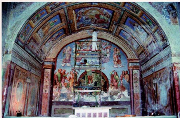
Interventi di consolidamento sull'arcata maggiore
