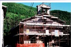
La Chiesa durante le fasi di restauro
