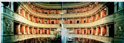
panoramica dei tre ordini di palchi durante i lavori di restauro
