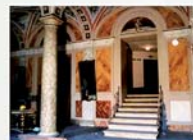
lavori di restauro dei finti marmi
