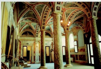
particolare del foyer durante i lavori
