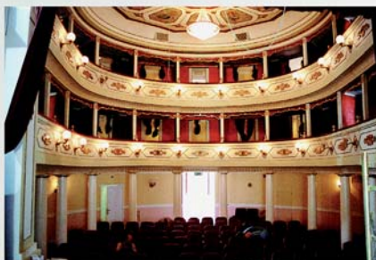
l'interno del teatro visto dal palcoscenico durante i lavori
