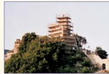
Durante i lavori di restauro
