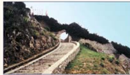
Cinta muraria prima dei restauri
