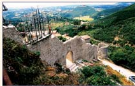
Cinta muraria dopo i restauri
