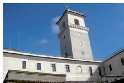
Fig. 2 - Vista della torre del palazzo dopo i lavori di restauro.
