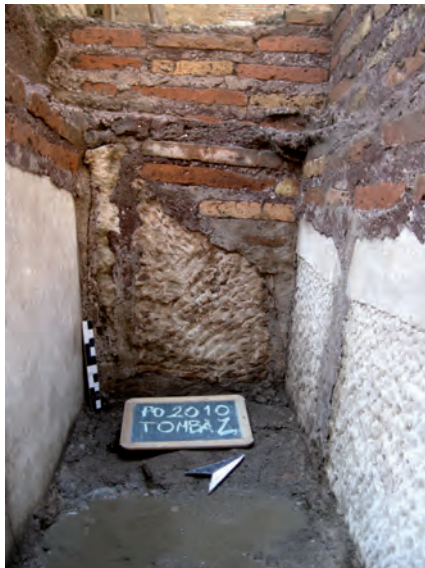
Fig. 7 - Paramento murario (Severo).
