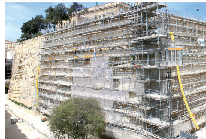
Durante il restauro delle Fortificazioni de La Valletta a Malta
