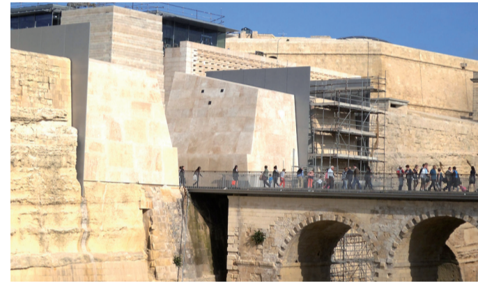
Dopo gli interventi di restauro delle Fortificazioni
