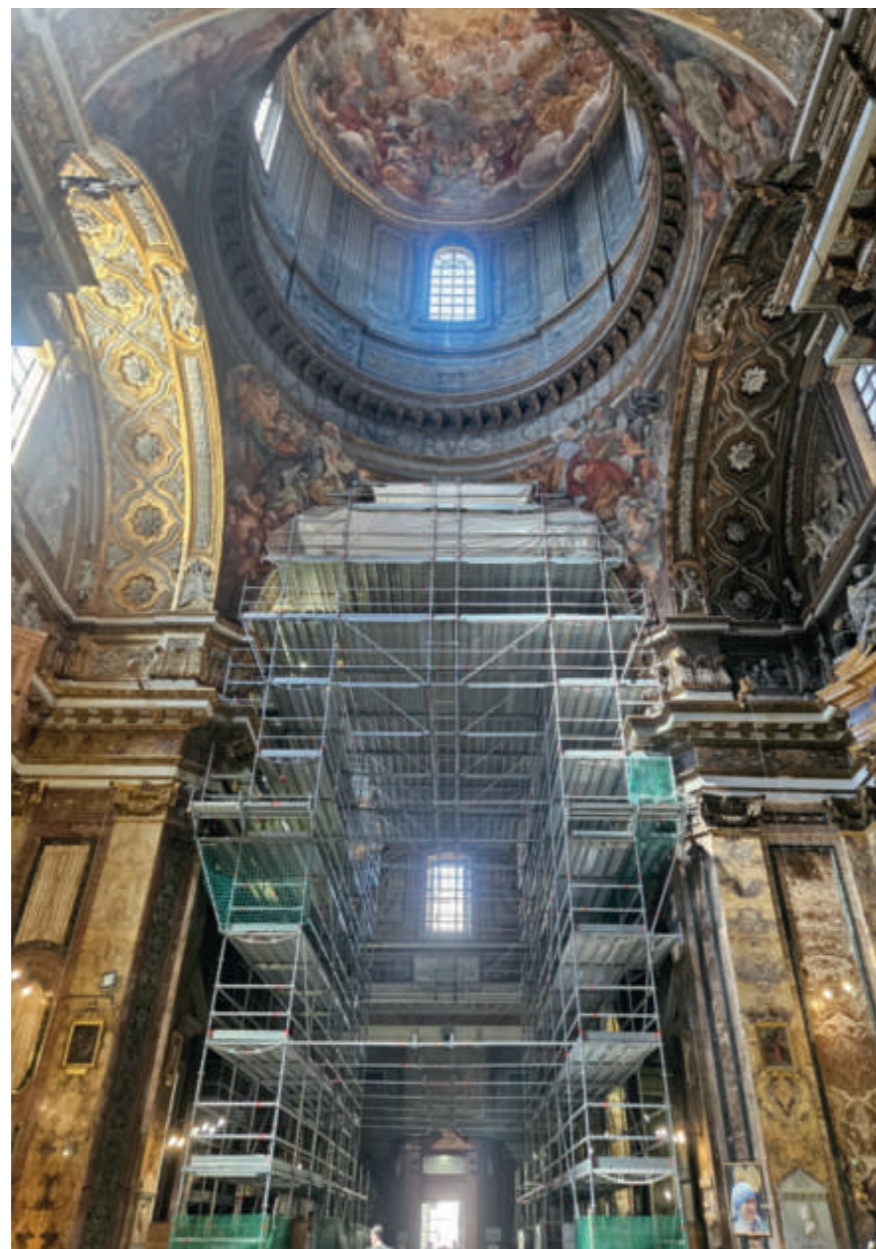
Sant'Andrea delle Fratte, l'interno della navata con i ponteggi e, nella pagina accanto, particolare della volta e degli elementi decorativi, durante il restauro. In basso particolare del colonnato del Chiostro, Basilica di Sant'Andrea delle Fratte. Courtesy De Feo Restauri Srl.
